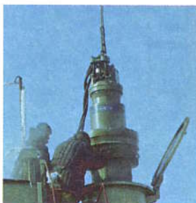
Рис. 6.13. Кабельные жилы осевого насоса могут переплетаться, если не применить рекомендуемые приспособления для их натяжения
