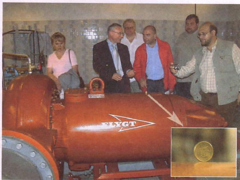
Рис. 1.11. Монета, поставленная ребром на работающий погружной насос не падает. Вибрация, шум, износ минимизированы
