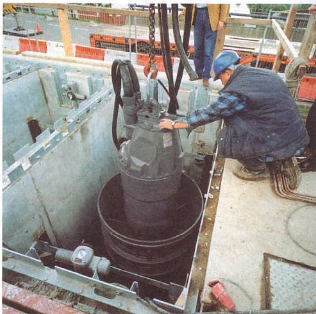
Рис. 6.13. Кабельные жилы осевого насоса могут переплетаться, если не применить рекомендуемые приспособления для их натяжения
