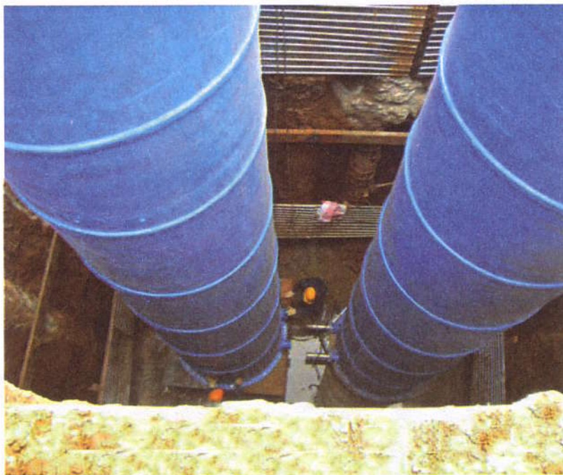
Рис. 5.66. Монтаж стеклопластиковых насосных станций «Эколайн»
