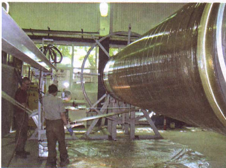
Рис. 5.63. Изготовление насосной станции из стеклопластика на ООО «Эколайн», г. Тольятти
